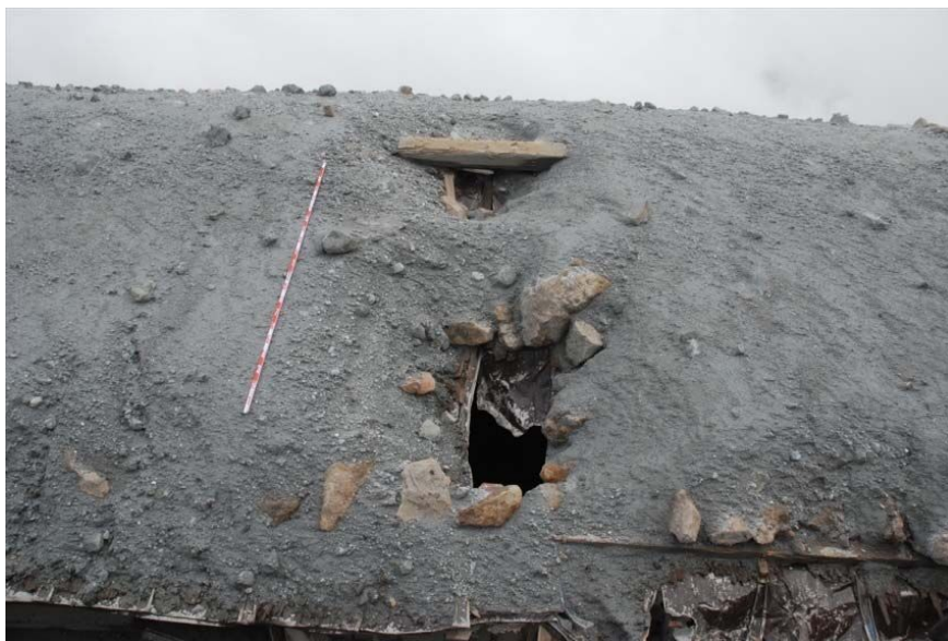
図1－4 御嶽剣ヶ峰山荘屋根の被害状況
