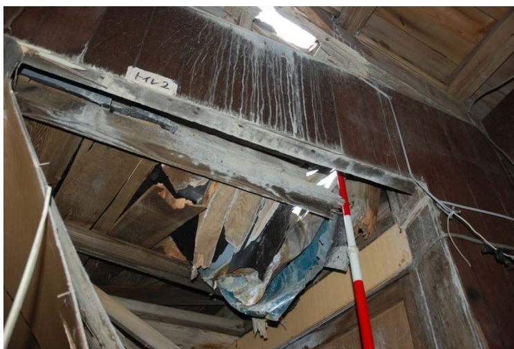
図1-7 二ノ池本館の噴石落下部位の小屋内部(2枚目の屋根で噴石停止)
