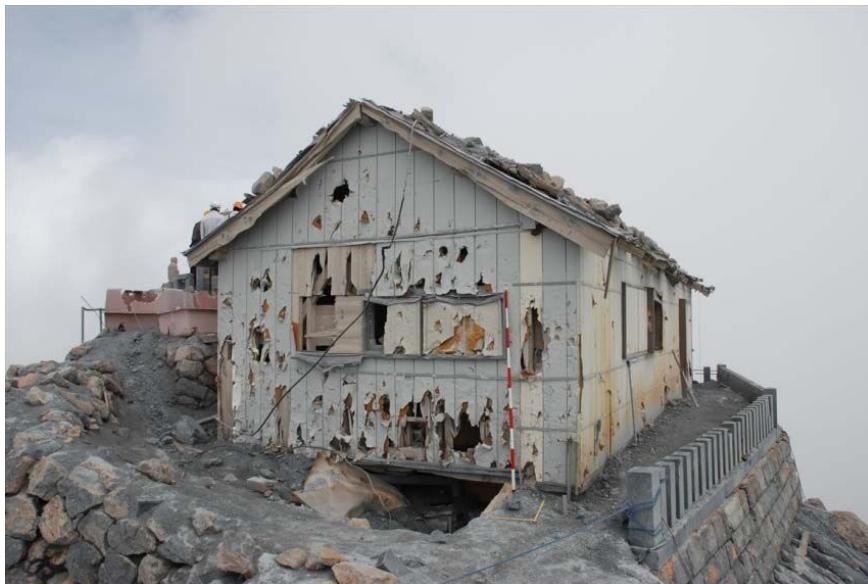
図1－3 御嶽神社頂上奥社外壁の被害状況
