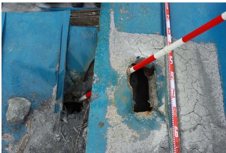
図1-6 二ノ池本館の噴石落下箇所(斜めに突き抜けている)
